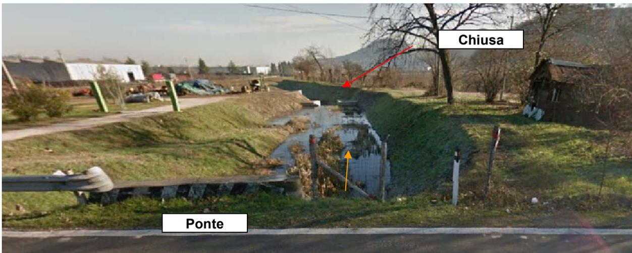
Ponticello costituito da una sezione di altezza  $H = 2\text{ m}$  e larghezza  $B = 3\text{ m}$ , sotto il ponte è presente un tombino con diametro  $120\text{ cm}$ . Dopo il ponte la sezione si allarga fungendo da invaso. Dopo una decina di metri è presente una chiusa di apertura  $2\text{ m}$
