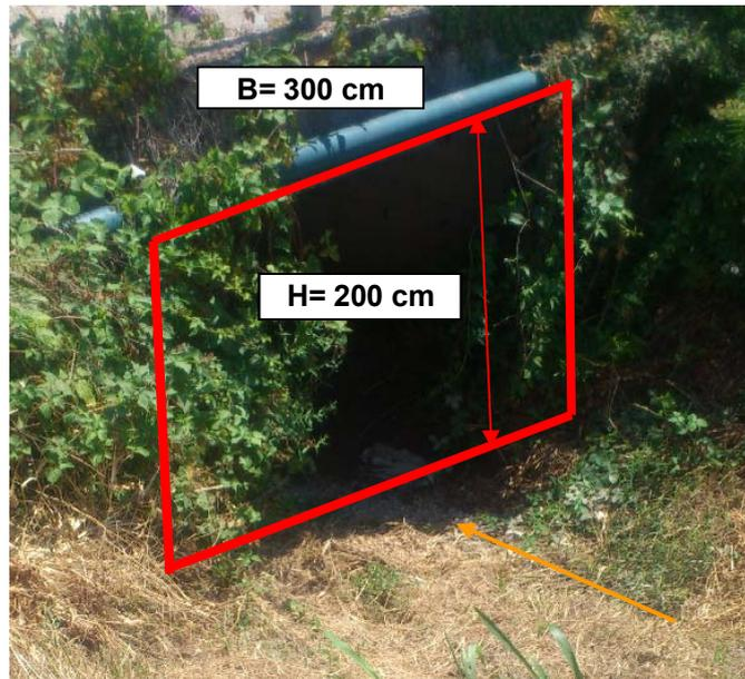
Ponticello accesso costituito da una sezione di altezza  $H = 2 \text{ m}$  e larghezza  $B = 3 \text{ m}$
