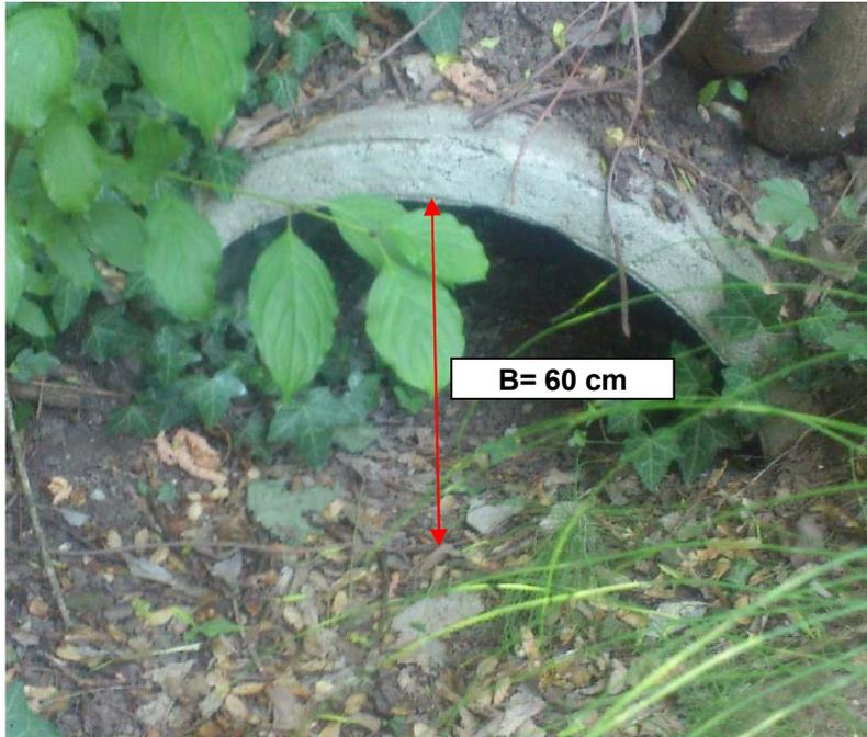
Ponticello costituito da una sezione circolare di diametro 60 cm più di metà interrato
